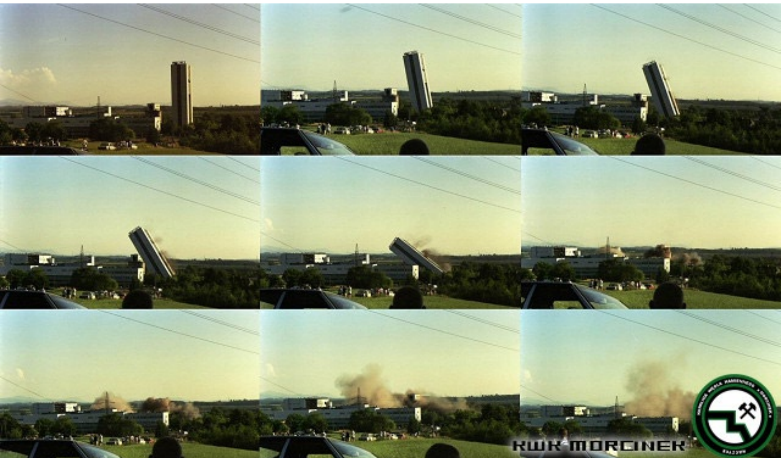
Wysadzanie Szybu II najnowocześniejszej polskiej kopalni węgla kamiennego “Morcinek” w Kaczycach na Śląsku Cieszyńskim. fot.: http://kwkmorcinek.kaczycy.net/galeria.php?s=galeria3
