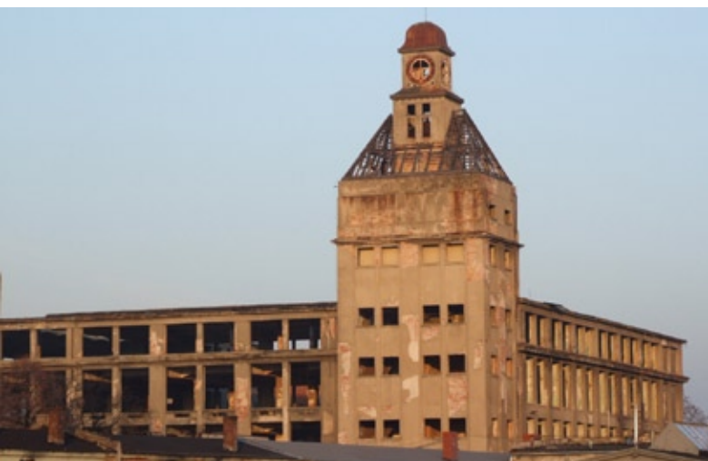
Ruiny Fabryki Nici “Odra” w Nowej Soli fot.: http://commons.wikimedia.org/wiki/Category:Nowa_Sól
