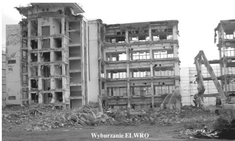
Wrocławskie „Elwro” wyburzane przez niemieckiego „Siemensa”
